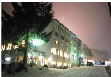
白樺湖ロイヤルホテル 2020年11月16-18日施工
