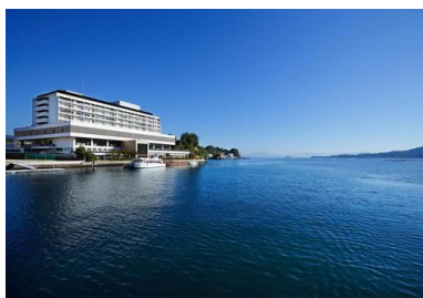
安芸グランドホテル 2020年12月15-17日施工
