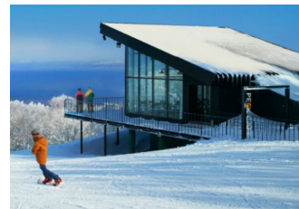
函館七飯スノーパーク 2020年11月11-12日施工
