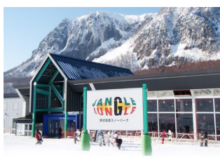
黒伏高原スノーパーク 2020年11月18-19日施工
