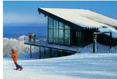
函館七飯スノーパーク 2020年11月11-12日施工
