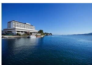
安芸グランドホテル 2020年12月15-17日施工
