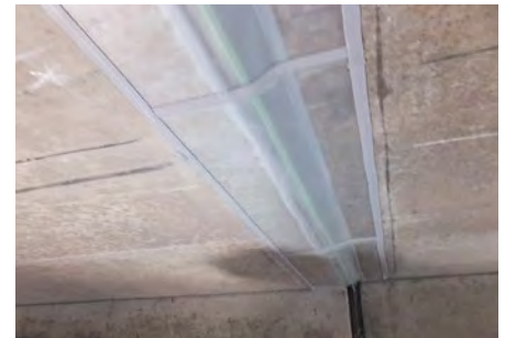
段差のある目地に施工した例
